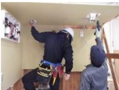
■実習板や実習場の設備を建築物と仮想して、電気工事に必要な工事の種類を学び、配線方法や器具の取り付け、電線管の加工・通線技術を学びます。
