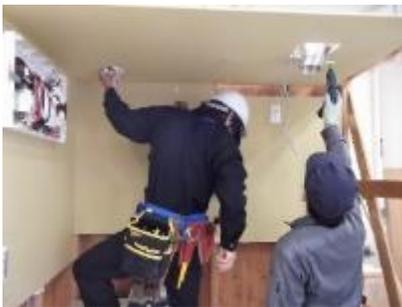
■実習板や実習場の設備を建築物と仮想して、電気工事に必要な工事の種類を学び、配線方法や器具の取り付け、電線管の加工・通線技術を学びます。
