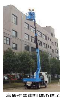
高所作業車訓練の様子
